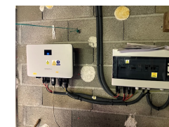
Onduleur et coffrets de protection courant alternatif (secteur) et continu (panneau photovoltaïque)00
