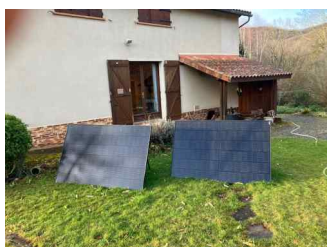
Kit 1 kWc « plug and play » posé au sol avec support amovible.
