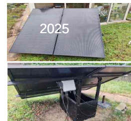
Kit 1 kWc « plug and play » posé au sol support amovible.
