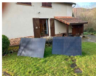
Kit 1 kWc « plug and play » posé au sol avec support amovible.
