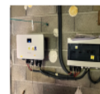
Onduleur et coffrets de protection courant alternatif (secteur) et continu (panneau photovoltaïque)00
