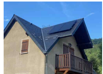
3 kWc sur plusieurs pans de toiturel.
