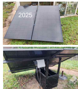
Kit 1 kWc « plug and play » posé au sol avec support amovible.
