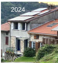
2,5 kWc + batterie 5 kWh
