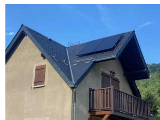
3 kWc sur plusieurs pans de toiturel.
